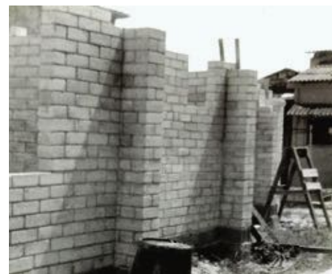
Figura 2. Construcción experimental de bajo consumo energético y material, en Cocosolo, La Habana, 1990-93, con bloques de suelo local estabilizados con cemento Portland (5-7%). Proyectistas: Alfonso Alfonso, Gabriela Peterssen y otros colaboradores del Programa del ISPJAE-RDA. Fuente: Archivo personal de Alfonso Alfonso.
