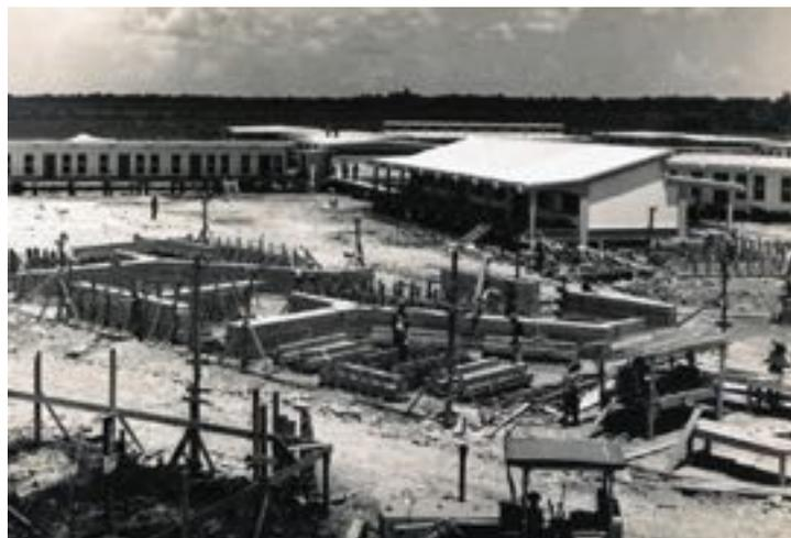
Figura 19. Estructura portante de comedores por columna-viga inclinada-monitor, prefabricada *in situ*, 1962. Fuente: Fondos del antiguo Ministerio de Obras Públicas. Archivo y Biblioteca Fernando Salinas, Empresa RESTAURA, OHC.
