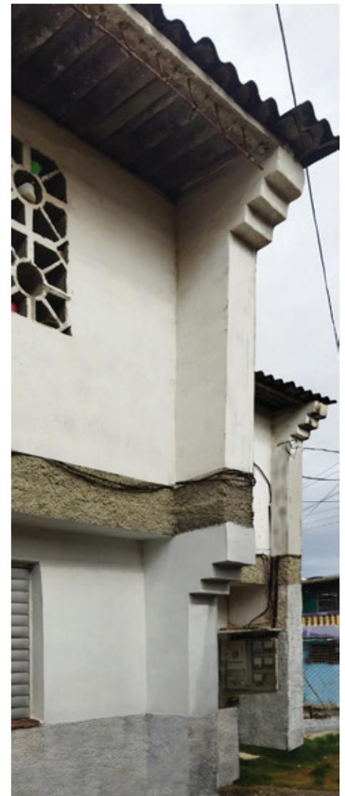
Figura 9. Vista de un detalle del edificio experimental de bloques prensados de suelo-cemento en Cocosolo. Fuente: Foto de los autores, 2024.
