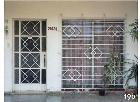
Figura 19. Tipos de cierres permeables, ventana tipo Miami: a) de madera con luceta y b) de vidrio. Fuentes: Autora.
