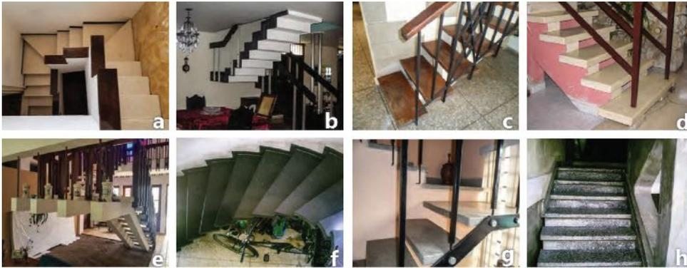
Figura 11. Escaleras: a) con varias ramas, b) ortopoligonal, c) con nervio central, d) con dos nervios apoyados, e) con dos nervios colgados, f) con pasos volados, g) mixta, h) adosada a nervio vertical. Fuente: A.J. Rouco, 2020.
