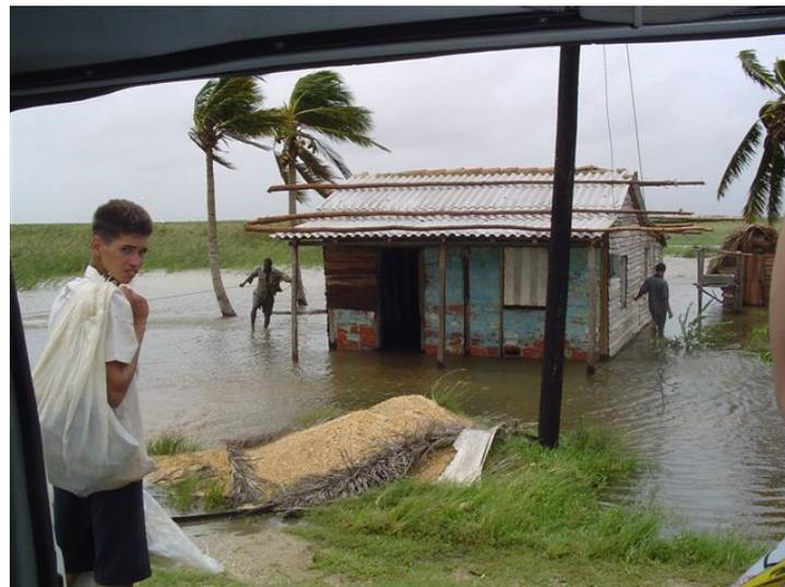
Figura 6. Reforzamiento temporal de un techo de asbesto cemento con palos rollizos ante la proximidad de un ciclón en Pinar del Río. Fuente: Cortesía de José Luis Hernández.
