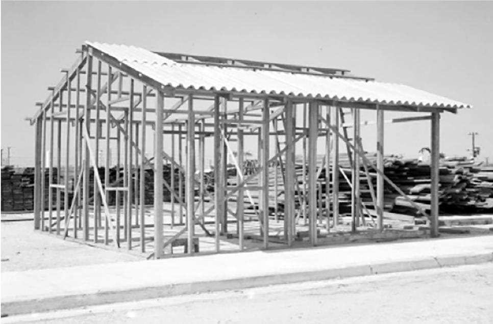
Figura 9. Esqueleto de madera, inspirado en las estructuras prefabricadas de Max Borges, que se utilizó en la elaboración de casas para los damnificados del incendio en la Playa Cajío, al sur de La Habana, 1950-1951. Fuente: Fondo del Ministerio de Obras Públicas, procesado y cotejado por el Lic. Juan de las Cuevas Toraya.
