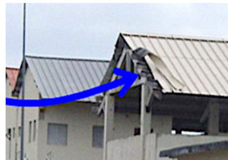
Figura 2. Desprendimiento de una lámina de metálica de borde por incorrecto diseño. Fuente: Autor.
