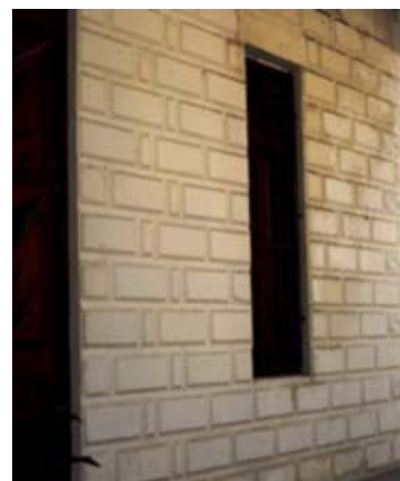
Figura 12. Detalle de terminación de la fachada de la casa pastoral. Fuente: Foto del autor.
