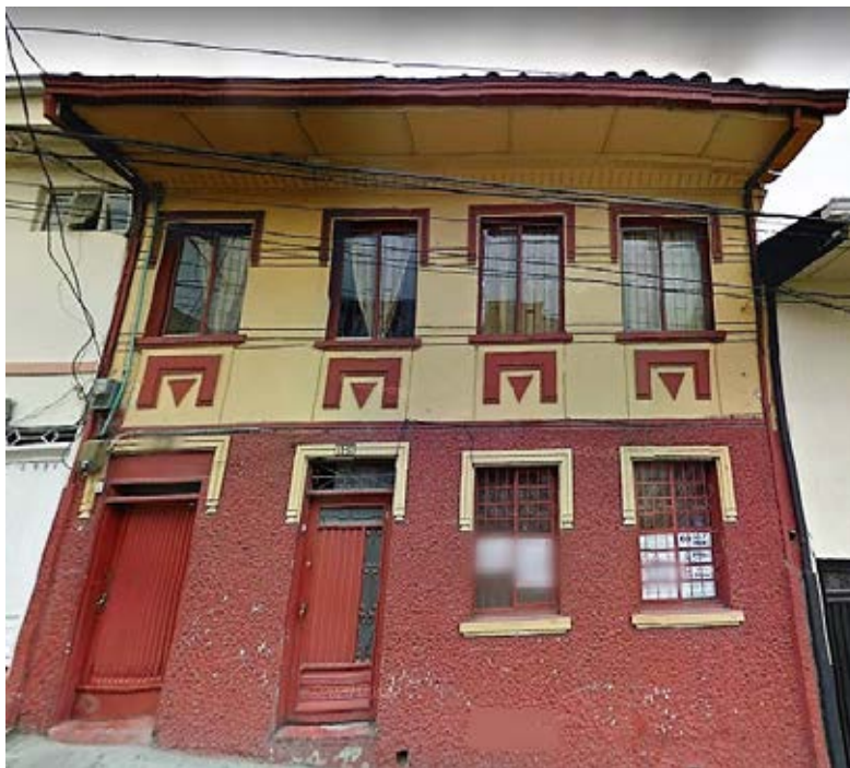
Figura 13. Vivienda localizada en la Carrera 26 #19-57, muestra la renovación de su fachada con posterioridad a su construcción inicial, conservando el bahareque de guadua y el alero de cubierta. Fuente: Google Maps. Recuperado el 22 de marzo de 2021. Map for 5.065117931837061, -75.51896516524235
