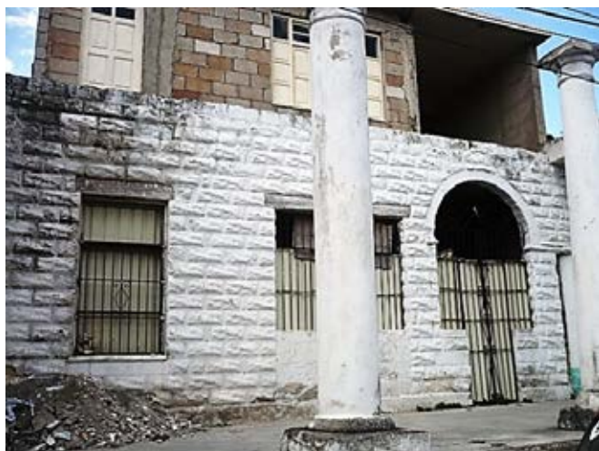
Figura 9. Fachada casa del misionero de la Iglesia. Fuente: Foto del autor.
