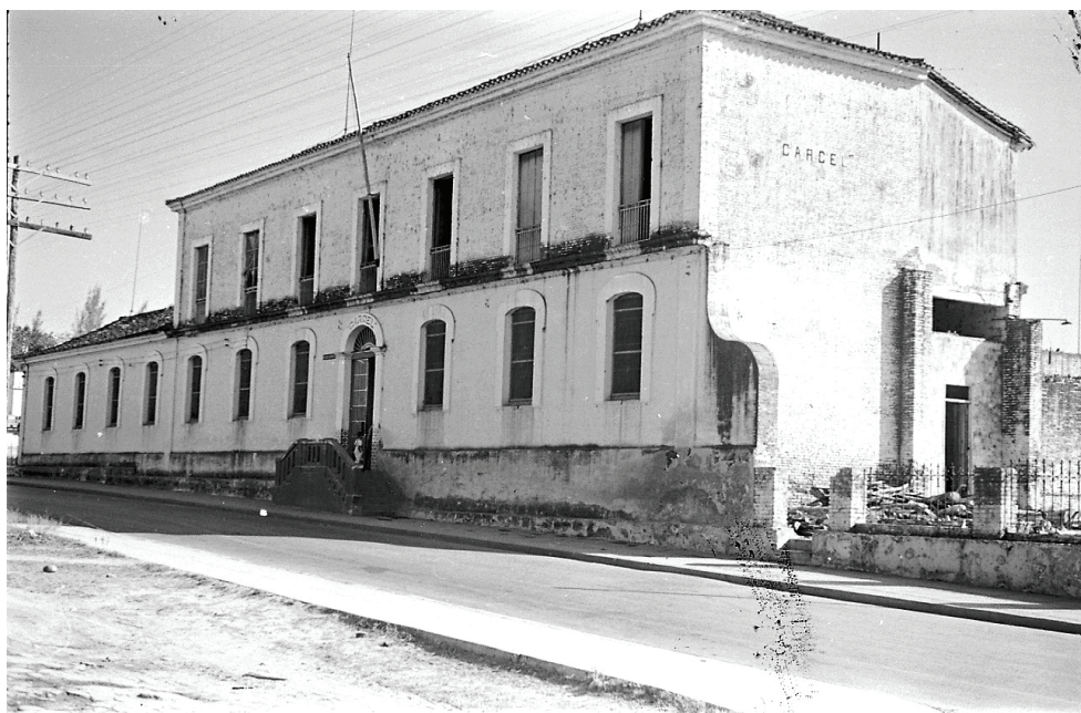
Figura 2. Fachada principal después de construirse la Carretera Central. Fecha posterior a la década de 1930. Fuente: Archivo del Centro Provincial de Patrimonio Cultural de Sancti Spíritus
