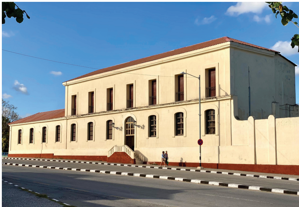
Figura 9. Fachada principal rehabilitada y completa. Fuente: Vladimir Osés, 2026.
