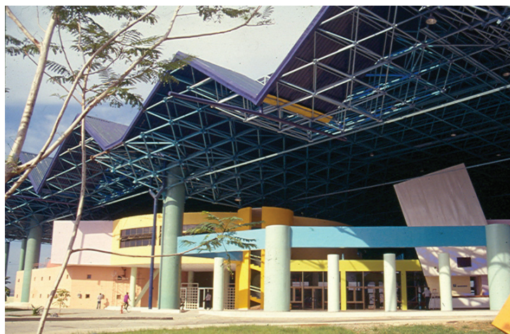
Figura 3. Terminal de Ferrocarriles, Santiago de Cuba (año de construcción: 1997). Foto: Eduardo Luis Rodríguez.
