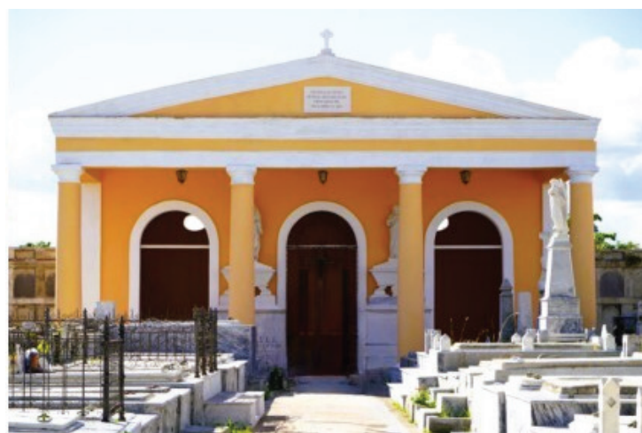
Figura 9. Acciones de conservación en el Cementerio de Reina, Cienfuegos. Fuente: Autores.
