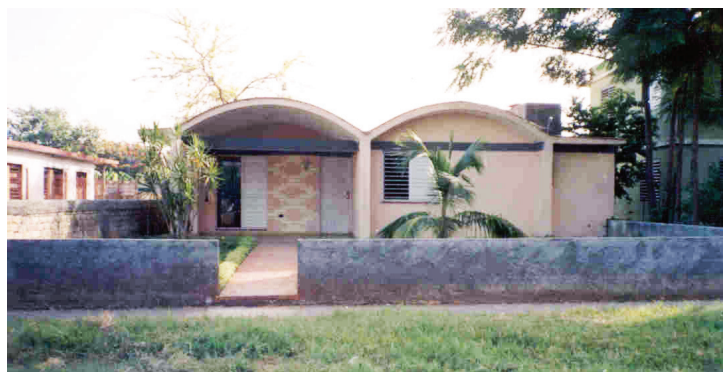
Figura 3. Viviendas construidas en Cuba en los años 90. Primera vivienda experimental construida con bloques machihembrados de suelo cemento en Matanzas. Fuente: Autores.
