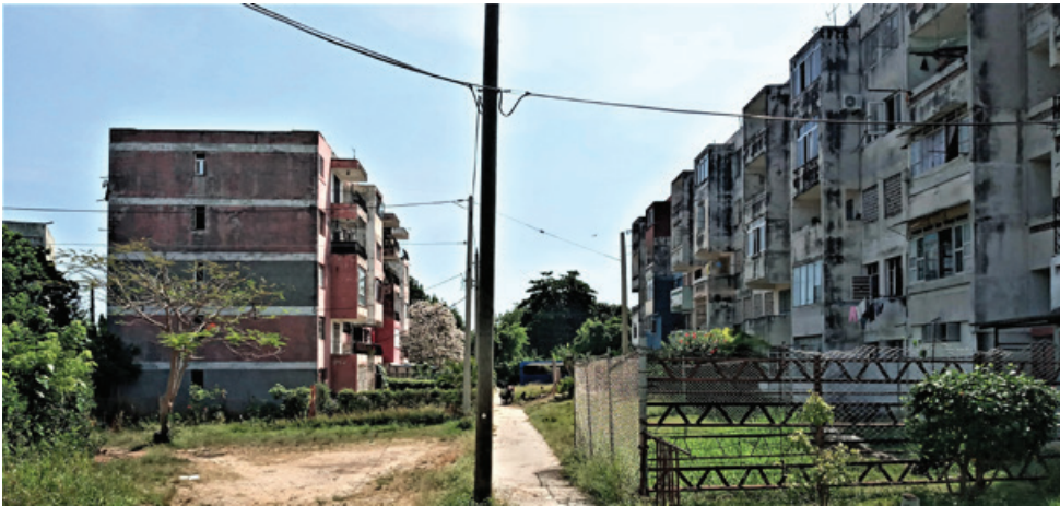
Figura 1. Ejemplo de un conjunto de edificios típicos en áreas de nuevo desarrollo en Alamar, La Habana. Fotografía del autor, 2025.
