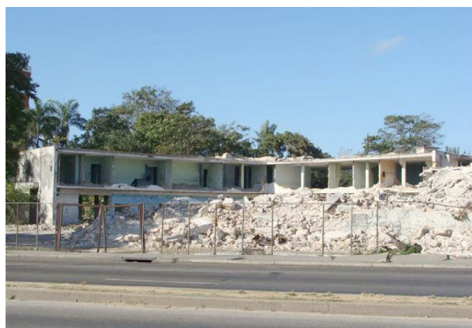
Ave. 31 entre 74 y 76, Playa. A diferencia de otros casos, este inmueble se encontraba en buen estado técnico constructivo, antes de su demolición.
