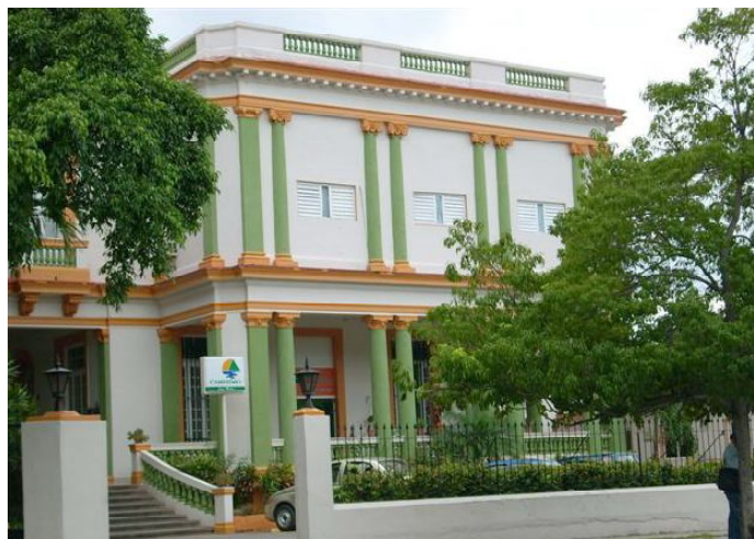
Modificación de vanos. Edificio en Paseo y 13, El Vedado.
