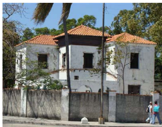
Esta importante vivienda, ubicada en la céntrica esquina de 41 y 44, Playa, ha sido abandonada y saqueada, ante los ojos de los transeúntes.*
