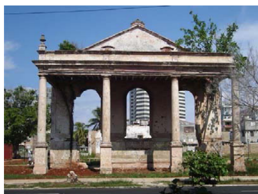
Restos del antiguo hotel Trotcha, un monumento a la desidia y a la falta de acometimiento y sensibilidad de las autoridades competentes.
