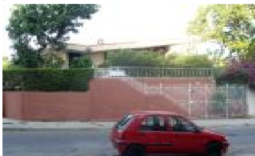
Casa Abad después de la remodelación
