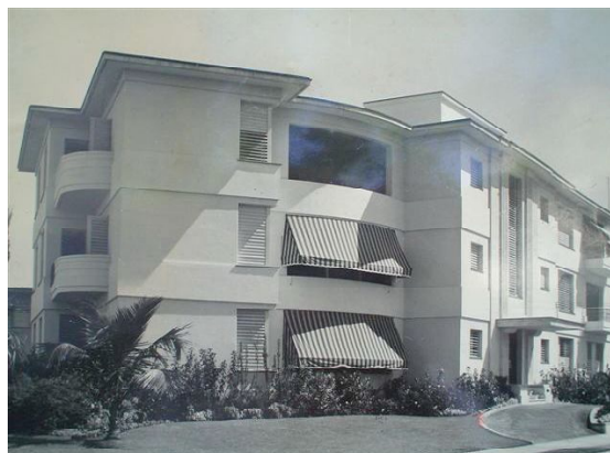
Antes de la intervención
