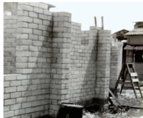
Figura 2. Construcción experimental de bajo consumo energético y material, en Cocosolo, La Habana, 1990-93, con bloques de suelo local estabilizados con cemento Portland (5-7%).
