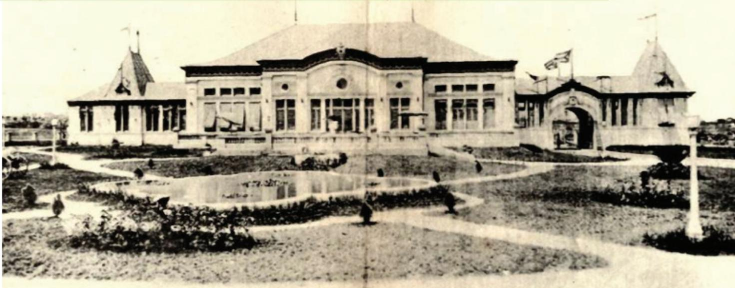
*Imponente imagen pétreo del Gran Casino Nacional (1919), construido con estructura de madera, malla metálica y mortero cementoso. Fuente: Cortesía del Lic. Juan de las Cuevas Toraya.*
