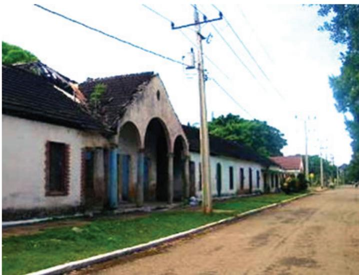
Figura 7. Antigua fonda y barracones del central Jaronú. Frontón realizado sobre una estructura portante de madera a la que se adosaba la malla norteamericana del tipo Self-Sentering. Fuente: Cortesía de Gerson Herrera Pupo.
