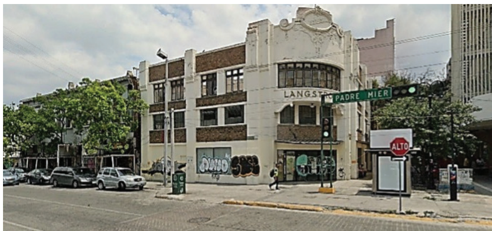
Figura 6. Vista exterior de la Casa Langstroth con diversos daños menores, sobre todo por grafitis y modificación de vanos en ambas fachadas en su parte inferior. Fuente: Google Earth (Ubicación 25°40'04.54" N 100°18'42.15" O), marzo de 2024.
