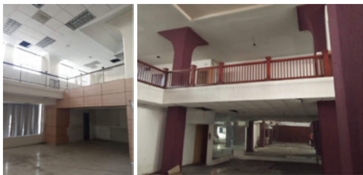
Figura 7. Vistas del interior del Edificio Langstroth antes de los retiros de algunos elementos agregados. Se observan las alturas, amplitud y flexibilidad de los espacios. Fuente: Autor, mayo de 2022.
