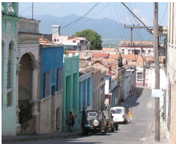
Imagen de la ciudad compacta donde predominan las viviendas.
