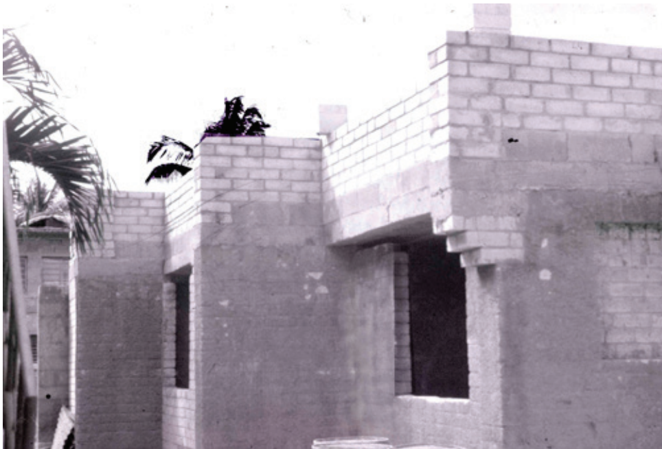
Figura 8. Prototipo experimental de dos plantas en fase de construcción con bloques prensados de suelo-cemento. FA- CECAT-WBT. Cocosolo. Fuente: Autores 1990.
