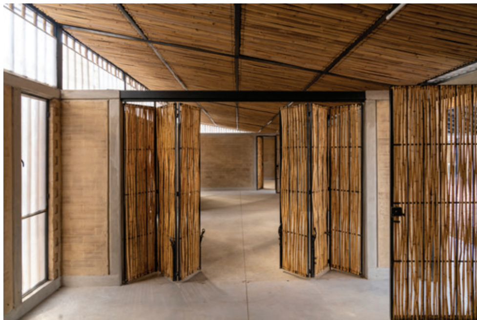
Figura 2. Materiales locales (carrizo y BTC). Foto: Jaime Navarro, 2021.
