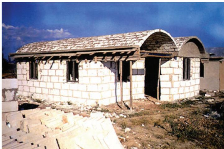
Figura 6. Vivienda en construcción en Matanzas con paredes de canto y cubierta de bóvedas del mismo material local. Es posible apreciar los tensores y aleros contrafuertes de hormigón armado para contrarrestar el empuje horizontal de las bóvedas. Fuente: Ruiz y otros, 1998.
