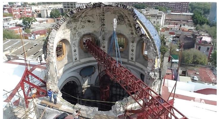
Figura 11. Fotografía donde se observa el proceso minucioso de montaje de las estructuras de acero. Fuente: SACBBE, agosto de 2020.
