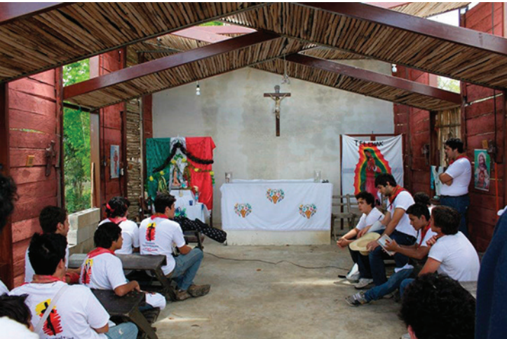
Figura 7. Capilla de Lázaro Cárdenas, Quintana Roo, México, con muros a base de tabloncillos de Palo de Tinte. Fuente: E.P., 2011.
