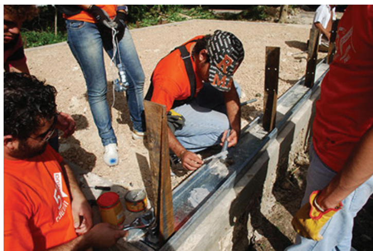
Figura 5. Colocación de grout en la tornillería para la instalación de los pies derechos de los marcos de las capillas. Pedro Moreno, noviembre de 2011. Fuente: E.P.
