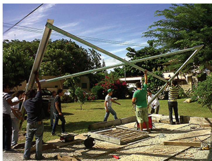
Figura 4. Pruebas de ensamble previas a la manufactura general de las piezas para las dos capillas. Fuente: E.P., 2022 (imagen de 2011).
