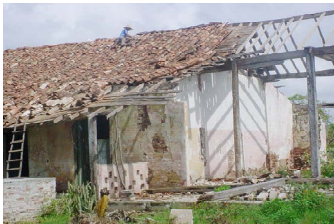
Desmante de la cubierta de la nave almacén.
