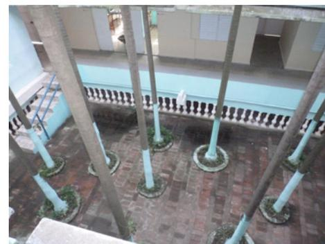
Figura 4. Detalle de patio interior en uno de los edificios de la Universidad Ignacio Agramonte, Camagüey, construido con el sistema prefabricado Girón. Se puede apreciar la incorporación de balaustres que no guardan relación con la concepción del edificio original. Fuente: autoras, 2016.
