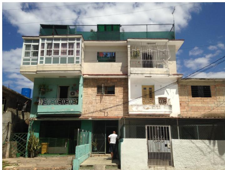
Figura 6. Edificio en el que se han realizado diferentes transformaciones, como: ampliaciones en áreas comunes, cierre de terrazas, adición de rejas y muros, y ampliaciones en la azotea. Querejeta, Playa. Fuente: Autoras.
