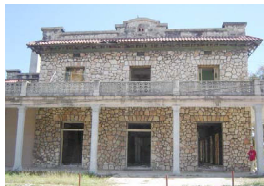
La majestuosidad de las construcciones de piedras es un signo distintivo dentro del conjunto. Antiguo hotel.
