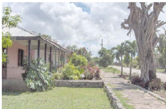
Barrio Sur. Viviendas para trabajadores de bajo rango, sobre una trama urbana que conserva su estructura original.
