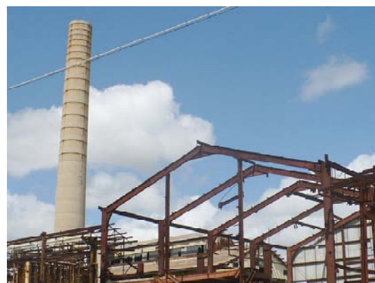
Las estructuras de acero, aún sin cerrar, pueden albergar nuevas funciones productivas, culturales y recreativas.
