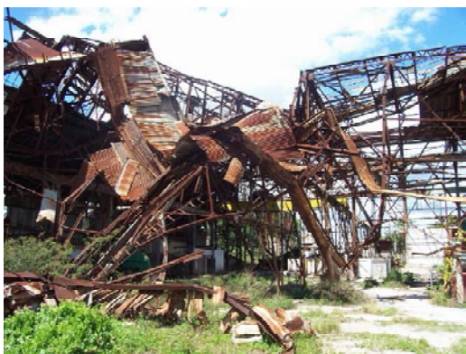
Desmantelamiento en el central Amistad con los Pueblos, en Güines.
