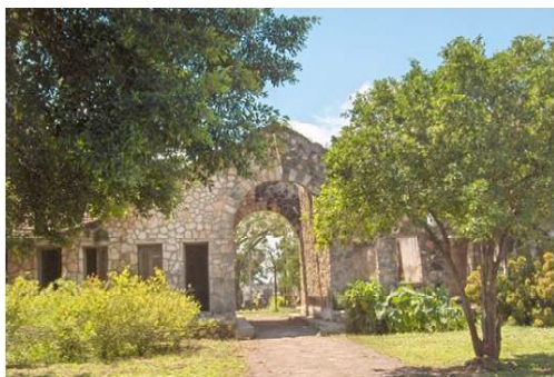
Patio interior de los barracones. Su comunicación hacia el exterior en cuatro direcciones, muestra una vocación decisiva en la interrelación urbana y el intercambio social.
