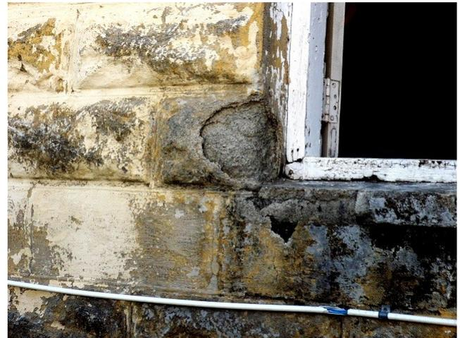
Figura 14. Detalle de los deterioros en el muro lateral de la fachada de la iglesia por la calle Libertad. Fuente: Foto del autor.
