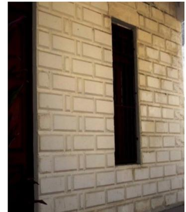
Figura 12. Detalle de terminación de la fachada de la casa pastoral. Fuente: Foto del autor.
