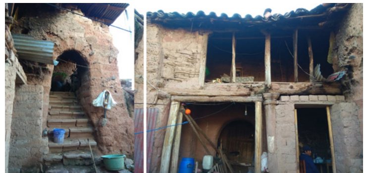
Figura 8. Revestimientos en muros de adobe y bahareque. Fuente: Autor.
