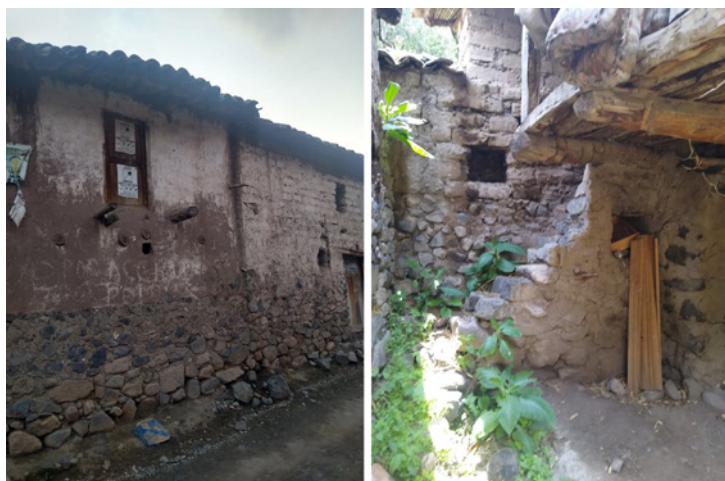
Figura 3. Muros de mampostería de piedra y barro. A la izquierda, fachada frontal donde se aprecia dichos elementos; a la izquierda, integración de muro y escaleras de acceso vertical. Fuente: Autor.
