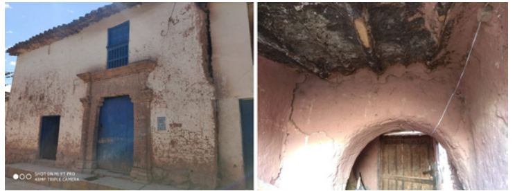
Figura 6. Muros de adobe en fachada y arquería en zaguán. Fuente: Autor.
