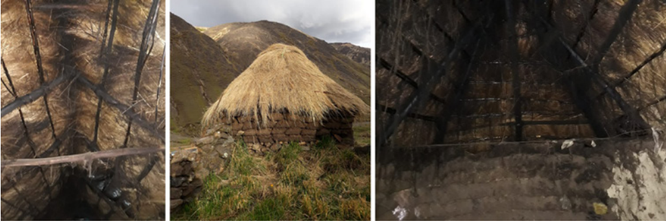
Figura 12. Estructuras de cubierta y material de cobertura. Fuente: Autor.
