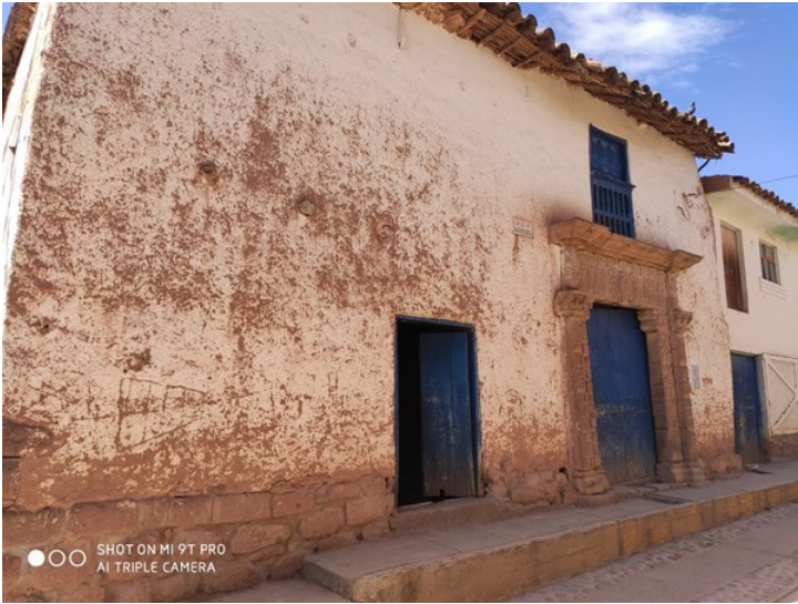
Figura 5. Fachada de vivienda tradicional con portada de piedra labrada. Fuente: Autor.
