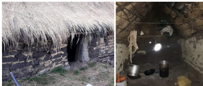
Figura 11. Dinteles de champa y pisos de tierra. Fuente: Autor.
