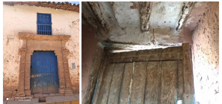
Figura 7. Ventanas con balaustres y portón con hojas de madera. Fuente: Autor.
