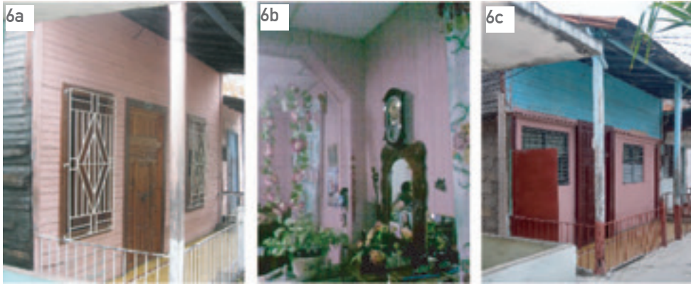
Figura 6a. Fachada de la Vivienda 657, Zona 1. Fuente: Autora, 2010.
