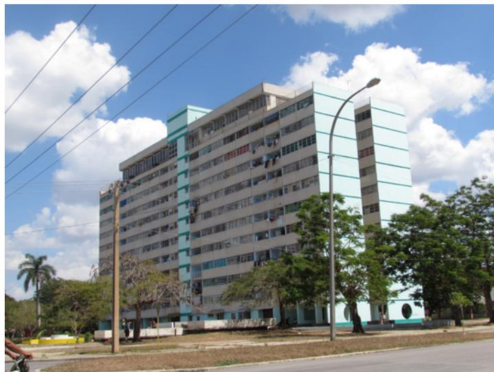
Figura 10. Edificio de viviendas construido con sistema SP 72, con restaurante en la última planta, ubicado en la ciudad de Camagüey. Fuente: foto de la autora, 2015.
