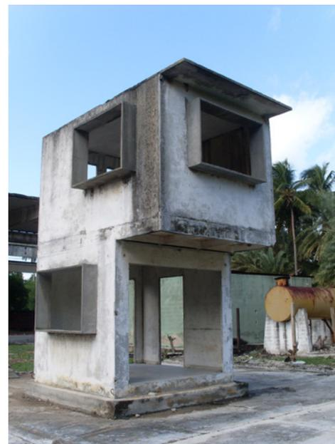
Figura 5. Prototipo experimental de unidad habitacional tridimensional prefabricada, aun existente en el Centro Técnico para el Desarrollo de los Materiales de Construcción. Fuente: foto de la autora, 2015.
