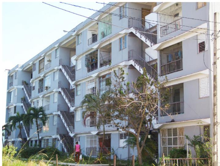
Figura 9. Edificio de viviendas construido por la Microbrigada de la CUJAE con el sistema SP 79. Fuente: foto de la autora, 2005.
