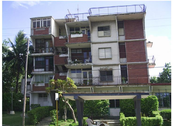
Figura 4. Edificio experimental de viviendas construido con Sistema constructivo Gran Panel VIII en el Micro Distrito Plaza de la Revolución en La Habana a finales de los 80's. Fuente: foto de la autora, 2002.
