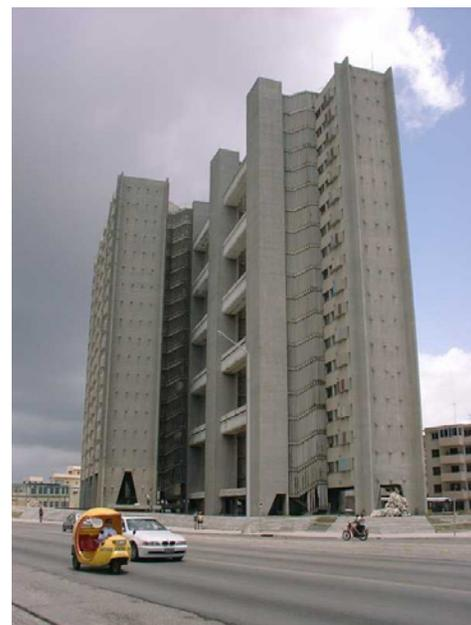
Figura 7. Primer edificio experimental de viviendas construido con sistema de Moldes Deslizantes en G y Malecón, el Vedado, La Habana. Fuente: foto de la autora, 2001.
