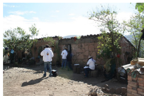
Figura 3. Vivienda vernácula en San Andrés Azumiatla. Fuente: autora.
