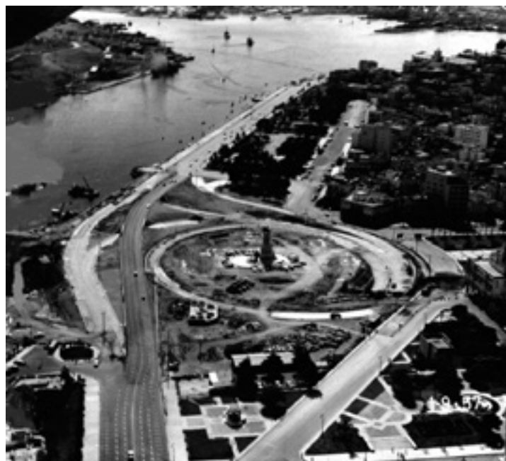
Figura 9. Foto de la construcción del túnel bajo la bahía en 1958. Fuente: Archivo Juan de las Cuevas.
