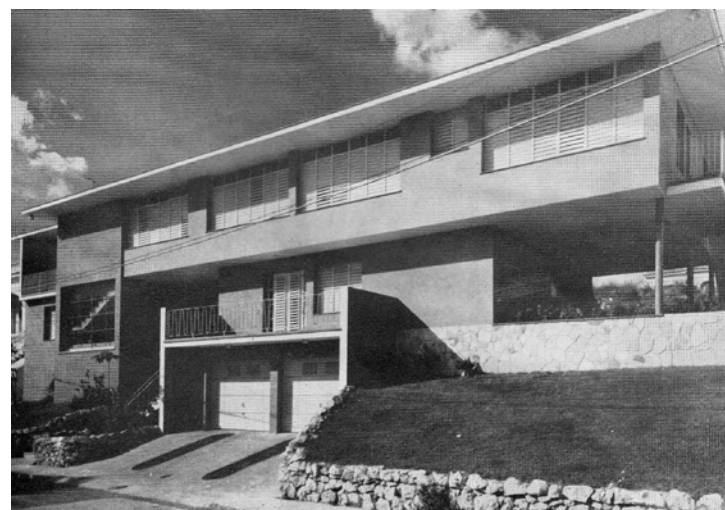
Figura 9: Residencia diseñada por el arquitecto Aquiles Capablanca en 1950 para el reparto Loma de Chaple, obra de estudio por su adaptación particular a la abrupta pendiente del terreno. Fuente: Álbum de Cuba, Volumen III, 1952.
