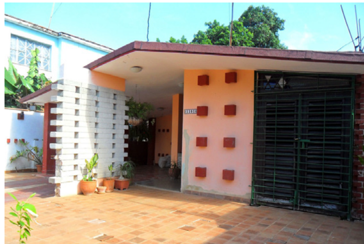
Figura 7: Ejemplos de soluciones constructivas y de terminación. Residencia diseñada en 1958 por Blanca Fueyo para el reparto Alturas de Palatino. Foto de archivo de los autores, 2016.
