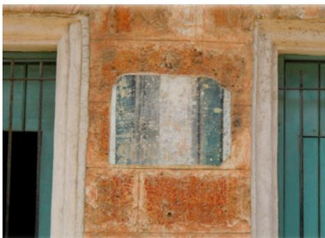
Figura 15. Testigo expuesto en la fachada de la escuela El Salvador, calle Teniente Rey, CH La Habana Vieja, que muestra el trazado decorativo de líneas y colores existente en épocas anteriores del inmueble. Fuente: Autor.
