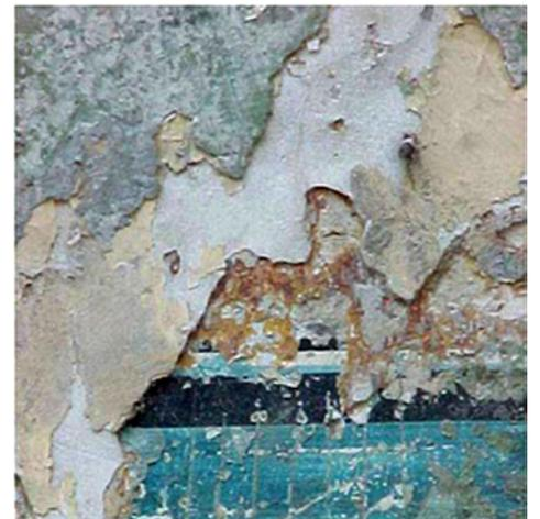
Figura 4. Proceso de deterioro de las capas pictóricas de un muro exterior en el Centro Histórico La Habana Vieja a causa de la acción de la intemperie y el transcurso del tiempo. Fuente: autor [2].
