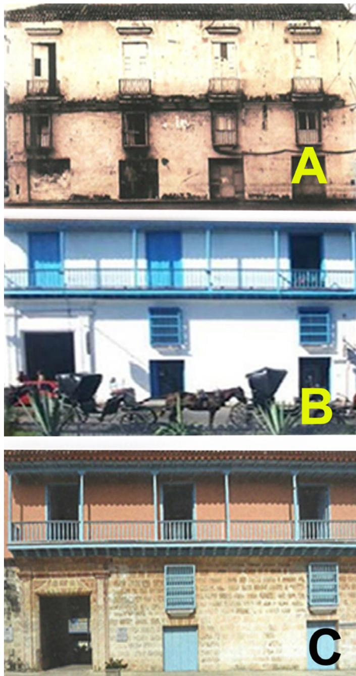
Figura 13. Tres estadios del color de la fachada de Tacón #4 en el Centro Histórico: (A): Fachada deteriorada del inmueble (B): Aplicación errónea de blanco, color que históricamente nunca fue aceptado por los Bandos de Gobierno. (C) Sustitución por un tono neutro en planta alta, diferenciado por un despiece expuesto en planta baja. Fuente: Archivo OHC.
