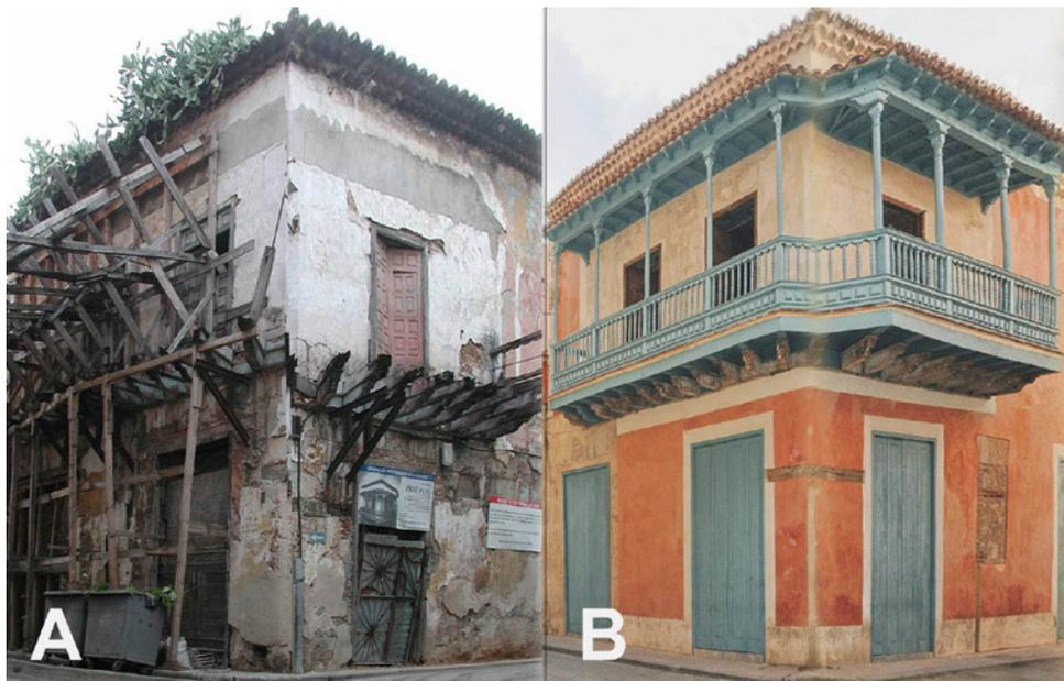
Figuras 5. (A) Deterioro avanzado de la casa esquinera de calle Aguiar # 159-161; (B) restauración posterior con reinterpretación libre de los tonos próximos a evidencias cromáticas. Fuente: autor [10].
