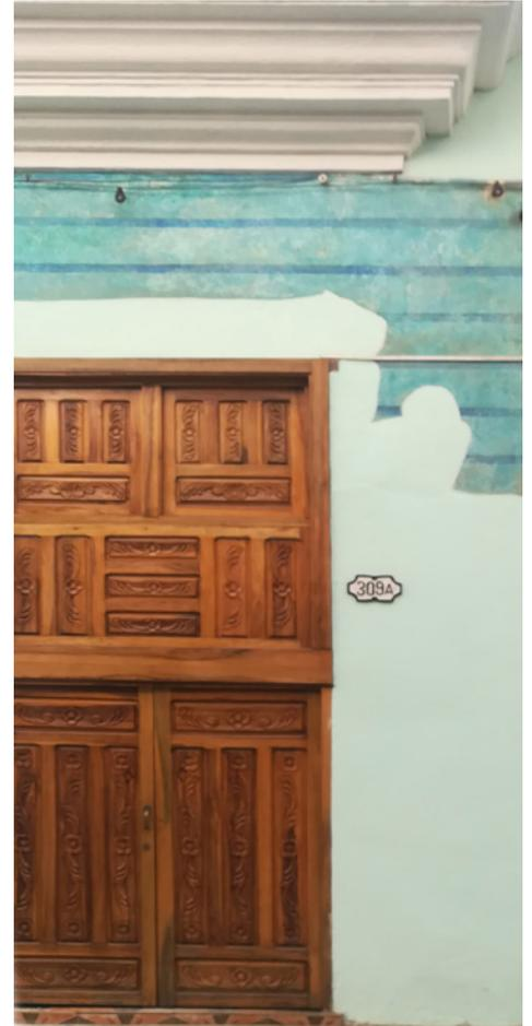
Figura 17. Testigo de color y delineado encontrados en la fachada de Obispo 116-117, que se conservó para recordar lo preexistente, mientras fue aplicada al resto de la superficie una versión reinterpretada del color original. Fuente: Autor.
