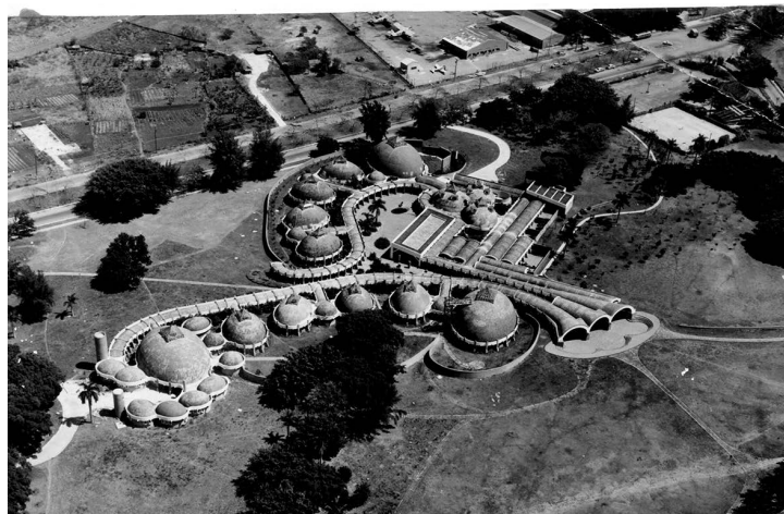
Figura 8. Escuela de Artes Plásticas. Ricardo Porro. Fotografía Archivo de la Oficina del Historiador de la Ciudad.
