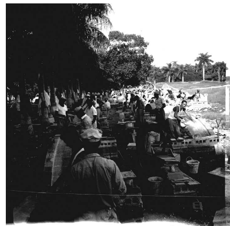
Figura 7. 1961. Escuela experimental de bóvedas tabicadas en los terrenos del campo de golf. Fotografía Archivo Vittorio Garatti
