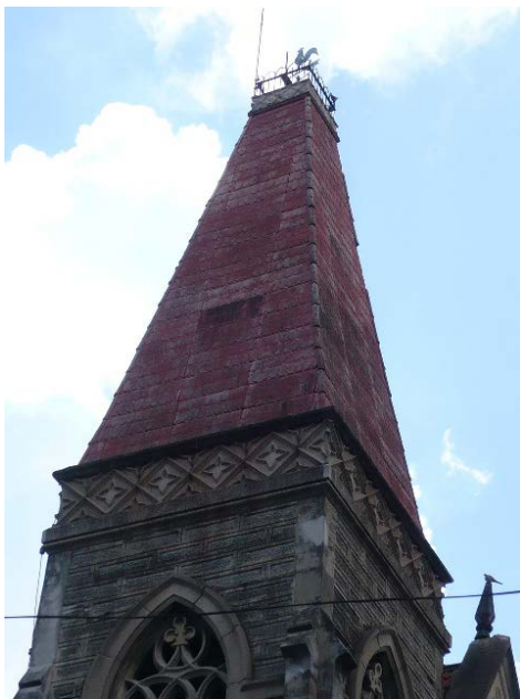
Figura 11. Cubierta de chapitel de la torre campanario. Fuente: autor.
