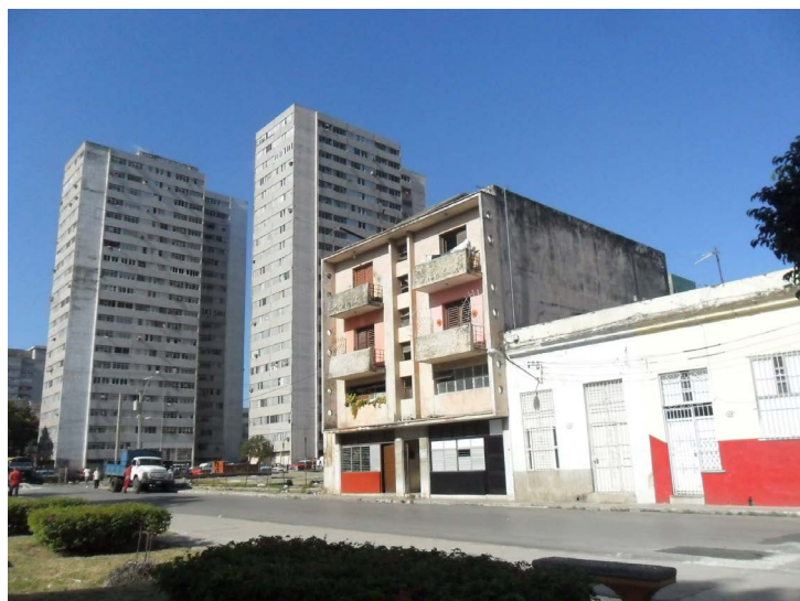
Figura 18: Edificio típico tipo torre ejecutado con sistema constructivo de Moldes Deslizantes en la Esquina de Tejas en la década del 70 (Foto de la autora, 2014).
