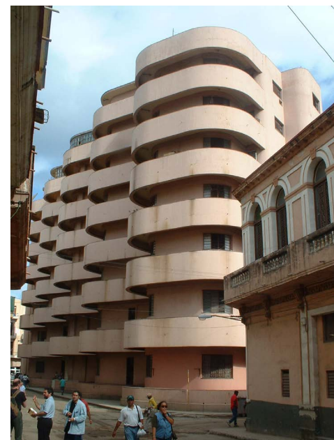
Figura 3: Edificio Solimar, Arq. Manuel Copado (1944). Las franjas horizontales que caracterizan la composición plástica constituyen pasillos de circulación que afectan la privacidad de los apartamentos (Foto de la autora, 2005).
