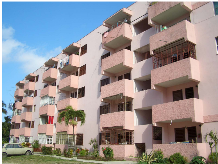
Figura 17: Edificio típico E 14 construido por la Microbrigada de la CUJAE en la década del 70. Sumatoria de módulos de tipología pareada (Foto de la autora, 2005).
