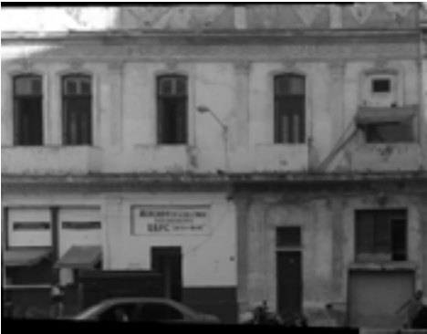
Figura 3. Fachada edificio San Lázaro 319 al momento de realizar el proyecto de refuncionalización. Fuente: autores, 2014.
