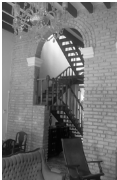
Figura 5. Escalera de acceso a la azotea construida con madera reciclada. Fuente: autores 2017.
