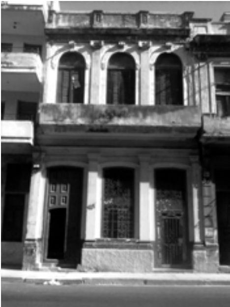
Figura 2. Fachada edificio San Lázaro 115 al momento de realizar el proyecto. Fuente: autores, 2014.
