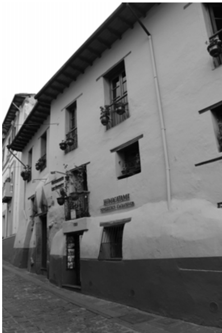
Figura 11. Fachada de la edificación La Ronda 762. Fuente: autores, 2018.
