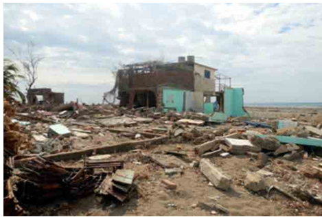
Figura 12. Estado en el que quedaron algunas viviendas y edificaciones sociales de Tipología Constructiva I. (Foto Milanés, 2012).
