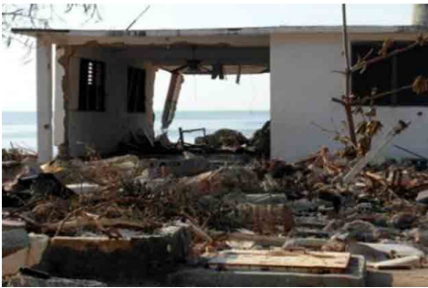
Figura 12. Estado en el que quedaron algunas viviendas y edificaciones sociales de Tipología Constructiva I. (Foto Milanés, 2012).
