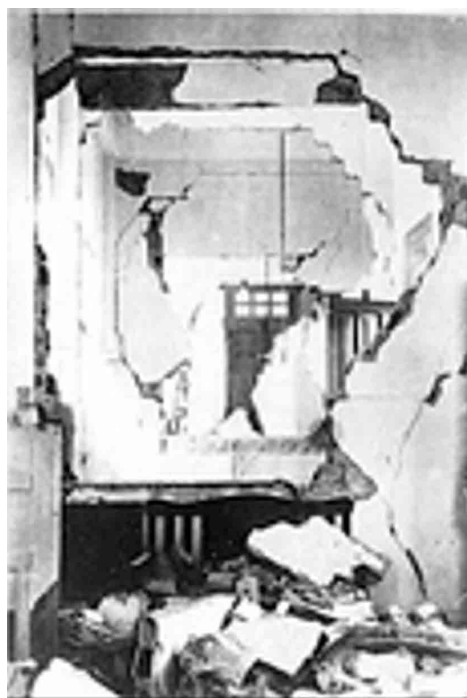
Figuras 8 y 9. Severos daños estructurales en el Edificio Swift & Co. Alameda y la Audiencia (Fuente: Fotos cortesía del Dr. T.J. Chuy).
