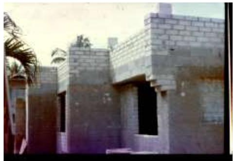
Figura 02: Edificio experimental de viviendas según diseño de A. Alfonso y construido en 1991-92 con ladrillos de suelo cemento en el barrio Cocosolo, en La Habana, con la colaboración directa del Departamento Tropenbau, HAB, Weimar, [Foto: autor]
