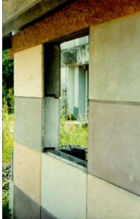
Figura 01: Muro experimental construido en el CECAT por Alfonso y Acevedo con paneles huecos ensamblables de cemento hidrófugo y terminación integral de las caras expuestas [Foto: autor]
