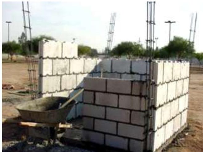
Figura 17: Muro de bloques-traba de excelentes propiedades resistentes y térmicas, elaborados con residuos de arena sílice y lodo de papel, desarrollados por investigadores de la UABC y colaboradores de esa universidad y del ISPJAE, [Foto: cortesía personal]
