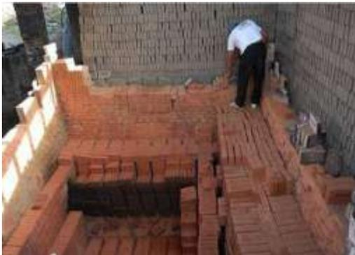
Figura 04: Construcción de ladrillos elaborados con residuos de origen minero, con el patrocinio de la UEAH, en México, para dar uso a los desechos minerales acumulados durante varias décadas en la localidad. Foto: [6].
