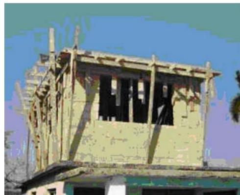
Vivienda construida con bloques y cubierta de losa plana de hormigón in situ con moldes de madera. Tesis de Diploma.
