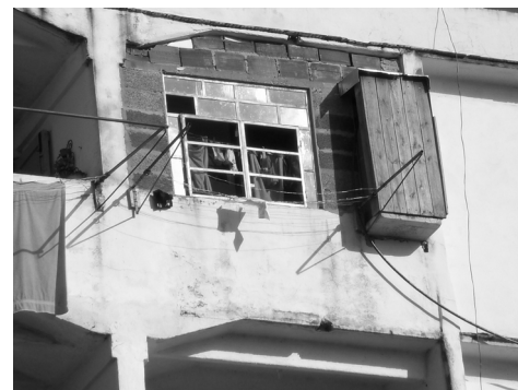
Figura 3. Ejemplo de transformaciones que ejecuta la población en los edificios de vivienda. Pinar del Río
