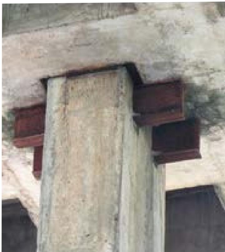
Figura 6. Unión vigas-columna sistema Losa izada. Fricción mediante cuñas de acero. Fuente: Elaboración propia.
