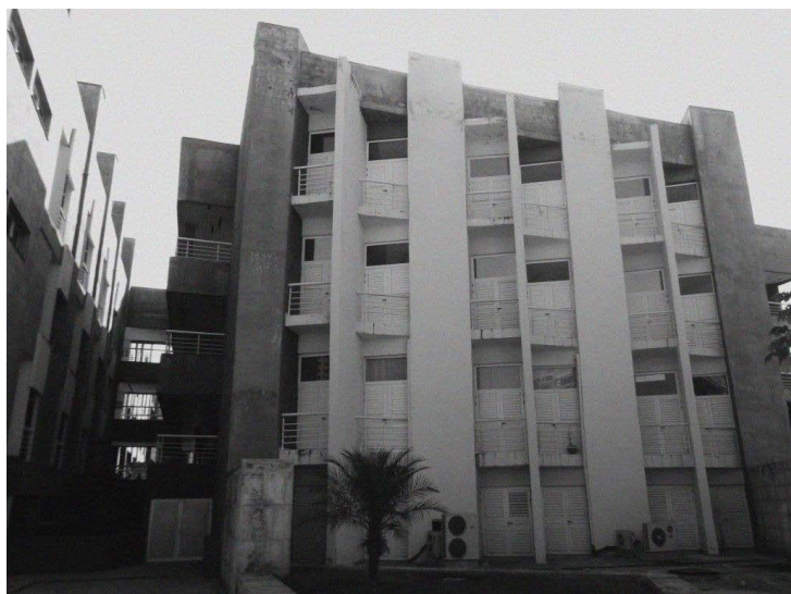
Figura 3. Fachada original del edificio evaluado.
