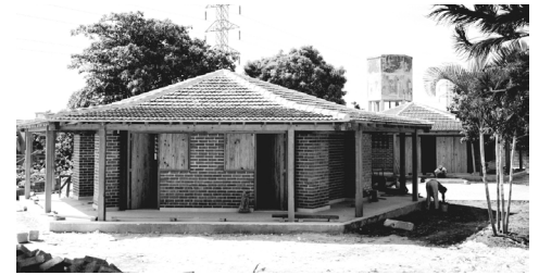
Figura 1: Escuela rural en Avenida Rancho Boyeros, La Habana. Arqs. Matilde Ponce y Alberto Robaina. Fuente: Fondo del Ministerio de Obras Públicas, procesado por Juan de las Cuevas.
