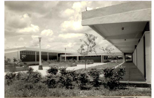
Figura 16: Escuela seminternada, Arq. Josefina Rebellón y Betty Fishman en la que se empleó un sistema de pórticos formados por columnas de alturas diferentes y vigas inclinadas. Cortesía Arq. Josefina Rebellón
