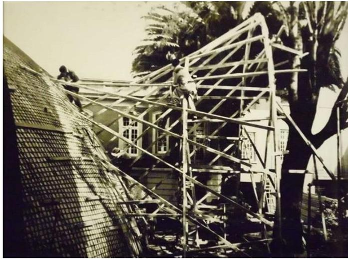
Trabajos de encofrado y refuerzo de acero en cubierta del cabaret Jacaranda.
