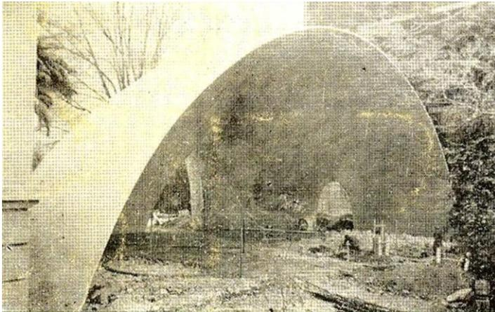
Figura 3. Estado de la cáscara al momento del desencofre. La concha fue calculada y construida por la empresa Cubiertas Ala, fundada por el Arq. Félix Candela en 1950
