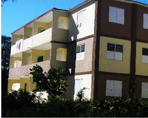
Figura 7- Fachada del Gran Panel Fuente: Foto tomada por las autoras.
