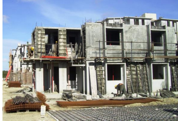
Figura 4. Detalles del proceso constructivo (mallas electrosoldadas y moldes de aluminio) Fuente: las autoras.
