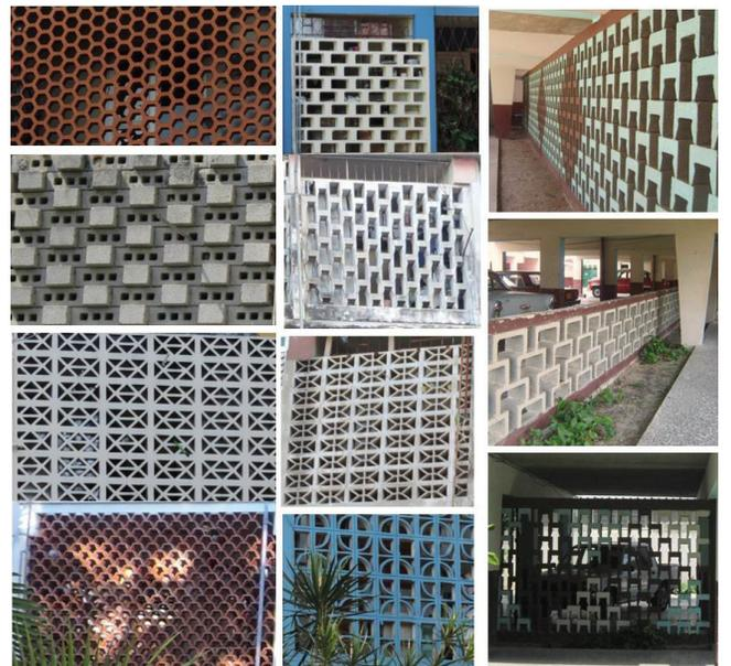
Fig. 17. Cierres de celosías en los edificios. Elaboración Autores
