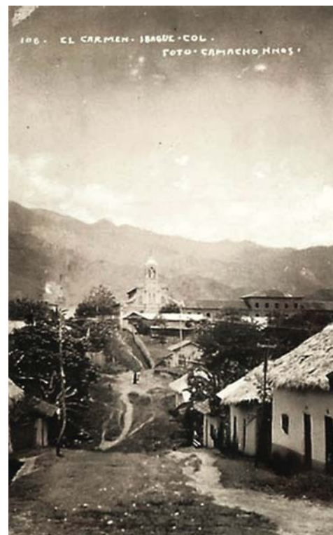
Figura 4. Segunda etapa de construcción. A la derecha de la iglesia se observan los tres cuerpos del claustro con mayor altura del central. Fuente: Fotografías antiguas y personajes del Tolima.
