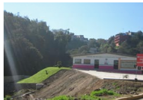
Figura 4. Obra terminada, se observa el muro de contención de piedra y block, en ladera de la barranca. Fuente. Autores.
