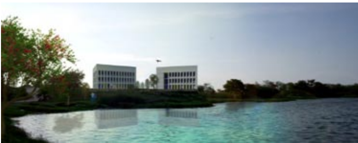
Figura 9: Bloques de aulas teóricas. En el terreno seleccionado se buscó aprovechar el paisaje natural circundante.
